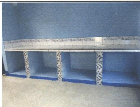
Foto 3: mejoramiento de cocina
