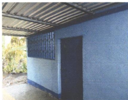
Foto1: mejoramiento de cocina
