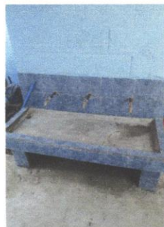
Foto 4: mejoramiento de lavamanos
