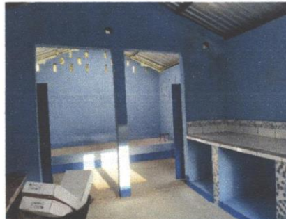
Foto 2: mejoramiento de cocina
